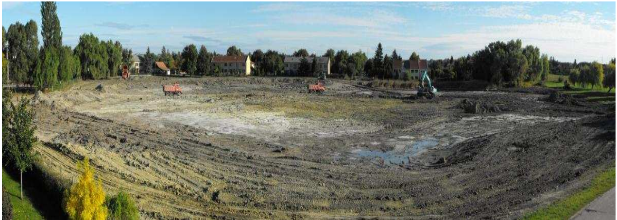
1. Kép: Tó kotrási munkálatai
